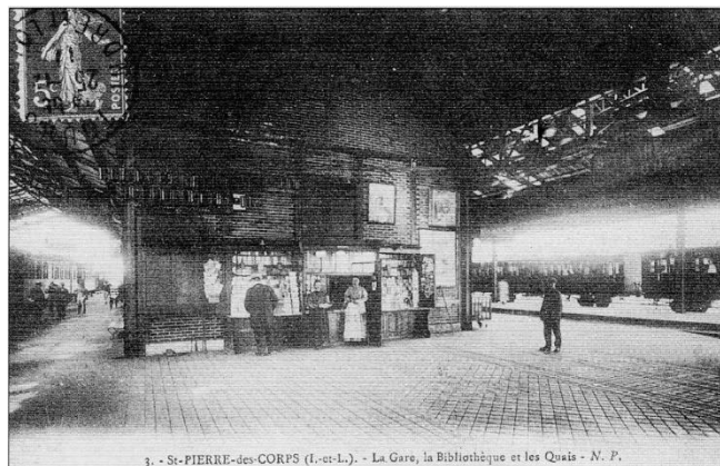
Intérieur de la gare de Saint-Pierre-des-Corps
