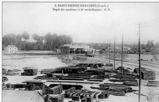
Le dépôt des machines ferroviaires et de ravitaillement vers 1911. On y entrepose rails, traverses, essieux, graviers pour les ballasts, etc.
